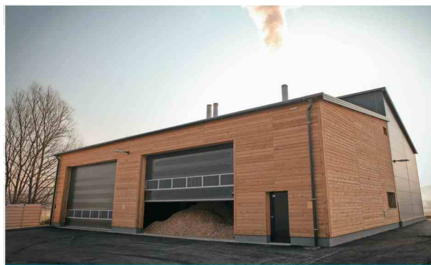
Kotlarna na lesne sekance, ki zaporniški kompleks na Dobu od letošnjega februarja ogreva izključno z obnovljivim virom energije.
