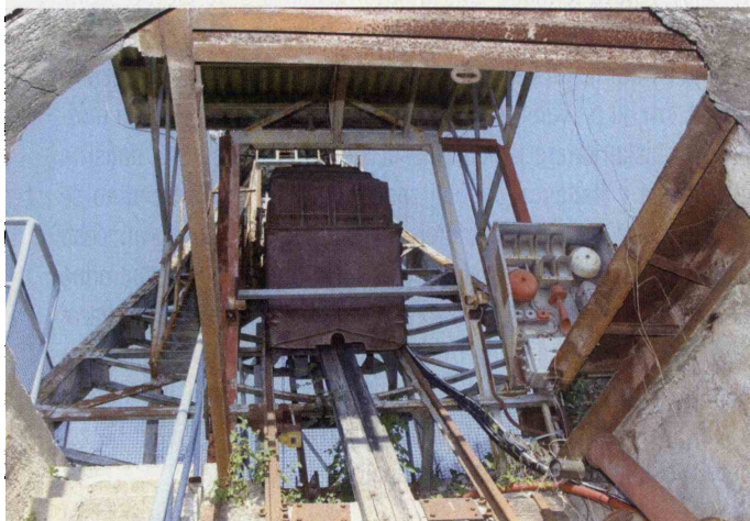
Pogled na izvozni stolp iz jame
